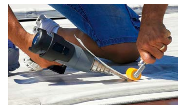
Soudage des bâches de toit
